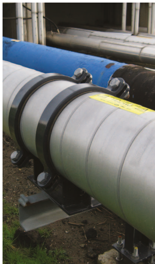
Podpory mocowane do zewnętrznej powierzchni rurociągu preizolowanego gwarantują jednakowe straty ciepła wzdłuż całej długości rurociągu.
